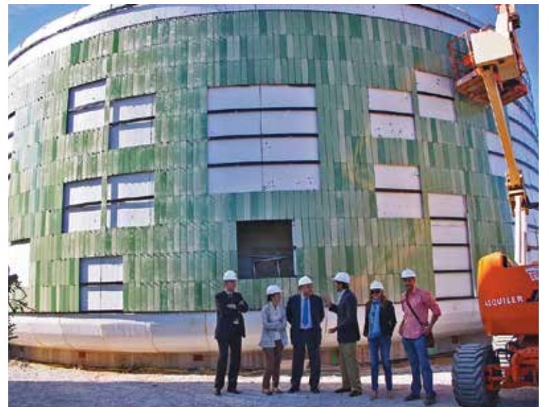
Imagen de la visita a las obras
