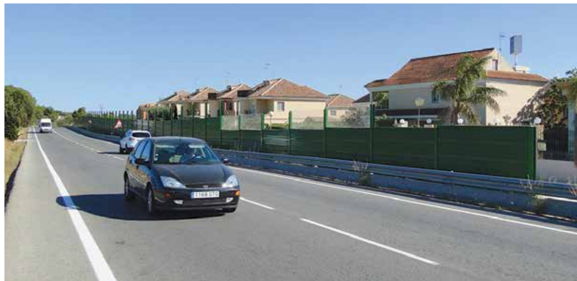
Pantallas acústicas instaladas en la carretera Pla del Pou
