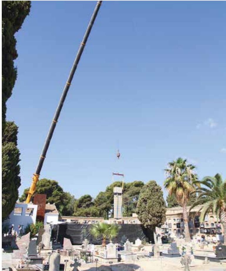
Instante en el que la grúa comienza a elevar el monolito
