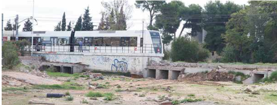
Lugar en el que se desbordó el agua del barranco que no pudo atravesar las vías
