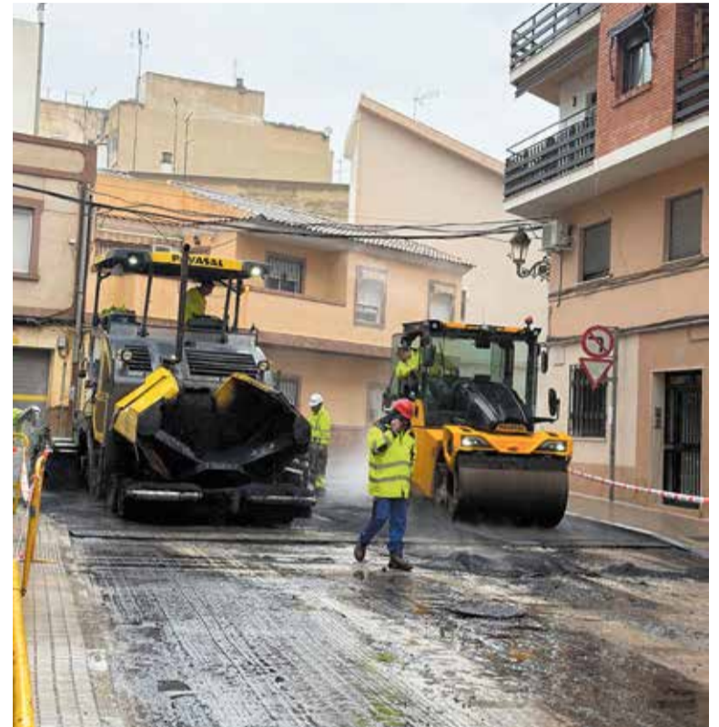
Asfaltado de calle tras instalar el nuevo colector de pluviales
