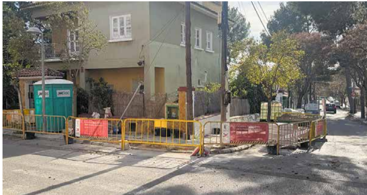
Obras de mejora en la vía pública en La Canyada
