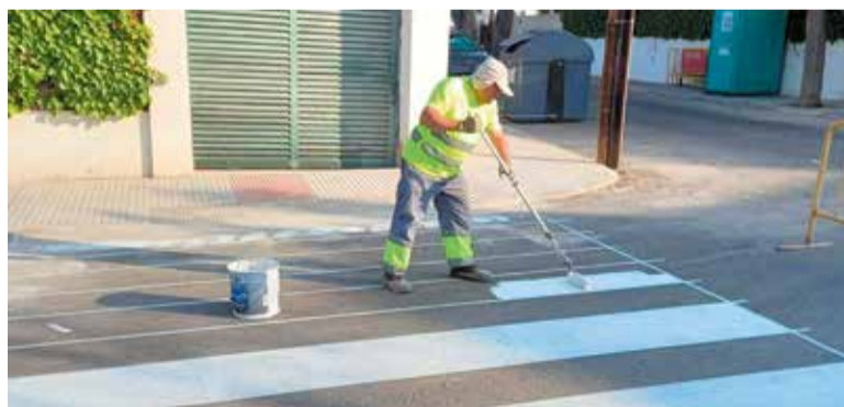
Trabajos de pintura en un paso de peatones en La Canyada
